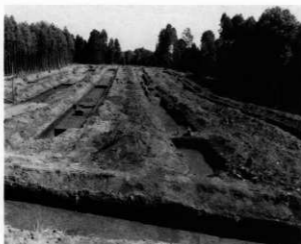
トレンチ設定状況
