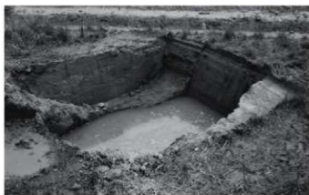
3. トレンチ9 (西から)
