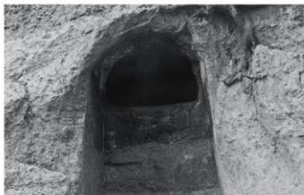
3. ST-010隔壁と玄門
