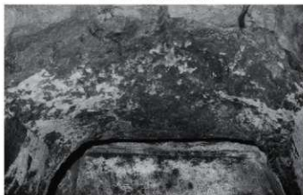
5. ST-010漢道天井
