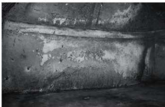
4. ST-007女室左側壁
