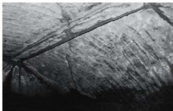
3. ST-009玄室天井（奥壁側）
