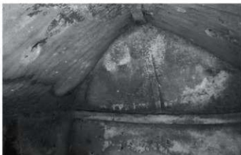
2. ST-007女室左側壁妻部
