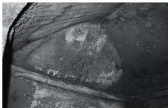
3. ST-007女室左側壁と天井
