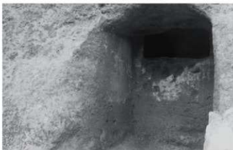
4. ST-006溪道左側壁と隔壁
