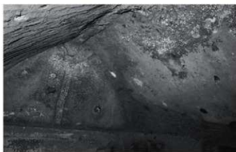
7. ST-007女室右側壁妻部
