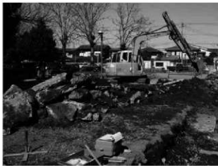
写真1 建築廃材の集積
