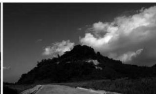
土取り削平状況（西より）
