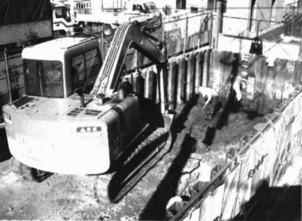
図5 機械掘削の状況。盛土を除去。
