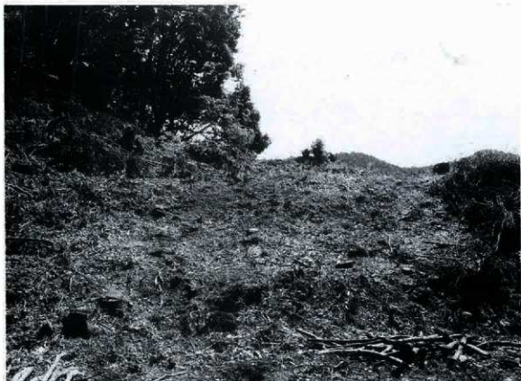
T-1 トレンチ草類除去後
