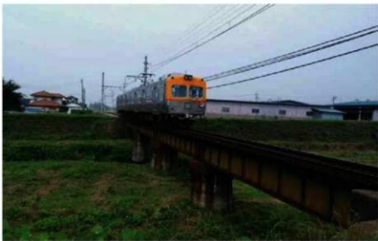
上毛電気鉄道柏川橋梁 カスリン台風により橋台と橋脚が崩れ、橋脚は当初の六角形から円形になった。構造は鋼版桁4連橋脚3基
