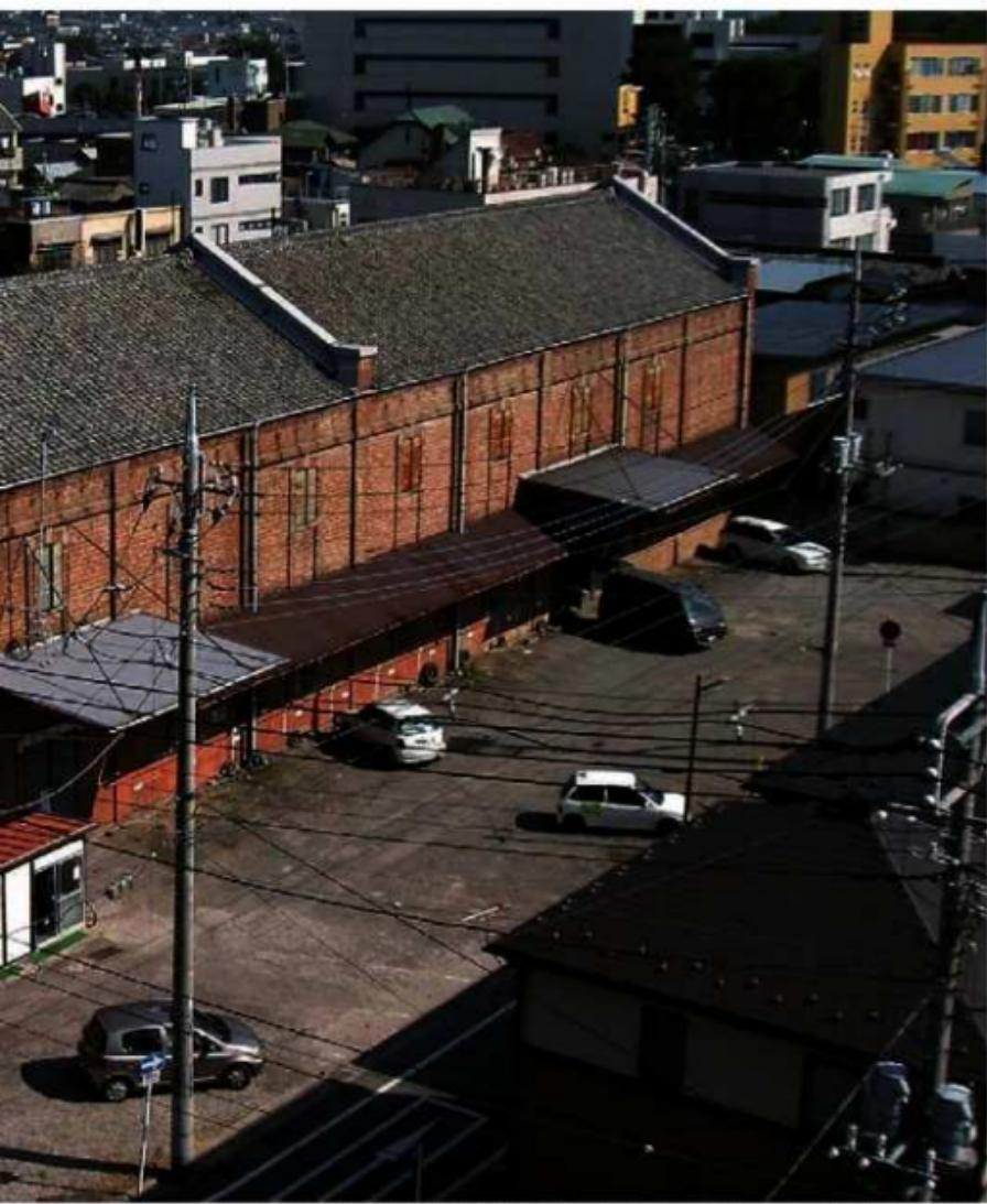
旧安田銀行担保倉庫(協同組合前橋商品市場倉庫) 貸付金の担保物件として繭や生糸を保管した。大正2年(1913)建築。桁行30間、梁間6間の2階建。煉瓦はイギリス積みである。
