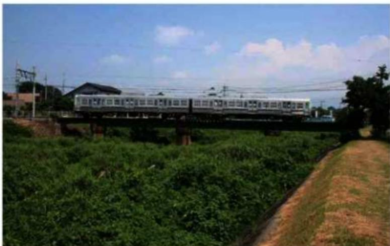
上毛電気鉄道荒砥川橋梁 当初の構造は2連の鋼板桁と橋脚1基であったが、昭和22年(1947)のカスリン台風により一部を流失したため、3基作り4連の橋梁となった。
