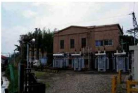
上毛電気鉄道大胡駅変電所 昭和3年(1929)に造られた。鉄筋コンクリート平屋建て。この変電所に送電する鉄塔も、昭和3年当初のものが4基残されている。
