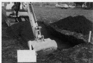
上層確認調査状況
