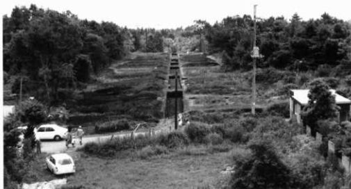
遺跡遠景（試掘調査中）
