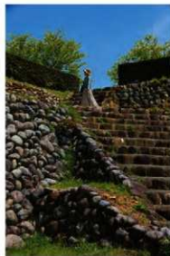
【A 北の丸から本丸を臨む】本丸は周囲の曲輪に比べ高く、その周囲は切岸を成していることがわかる。【B 松尾山背後の空堀】足元がすくむ程の高差と、眼下には巨大な空堀が展開する。【C 本丸虎口の玉石積み石垣】江戸時代には、小笠山麓から産出される古大井川の河原石が用いられた。【D 本丸天守台跡から南西を望む】18世紀初め頃までは南下に荒瀬による海が広がっていた。【E 本丸虎口】玉石積み石垣は、一見廃棄にも映るが、樹形虎口としての機能を十分もっていた。
