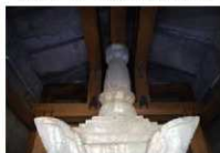
[写真 2-17] 石廟内部応急処置後
