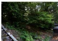
〔写真3-47〕上・下段間の斜面部
