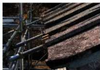
[写真 2-15] 石廟屋根板石調整後
