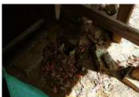
【写真3-50】排水路（門北西から）
