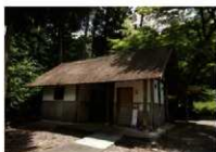
[写真 3-85] 徳源院参拝者便所
