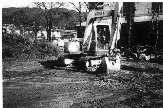
6. トレンチ埋めもどし作業
