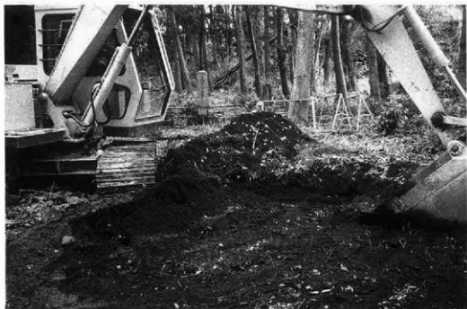
9. トレンチ埋めもどし作業
