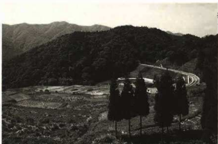
起し又遺跡遠景 (南より) 中央の重機付近が調査区
