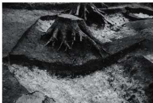
セクションB西掘削状況
