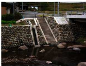
写真 45 河川護岸 (右岸)
