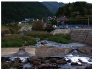
写真43 指定地北側の堰堤
