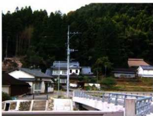
写真 48 電線と下小竹橋
