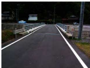
写真 49 下小竹橋橋梁
