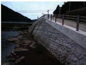
写真44 河川護岸（左岸）
