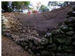
2工区背面盛土とグリ石
