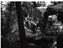
2工区（天守石垣）説明風景
