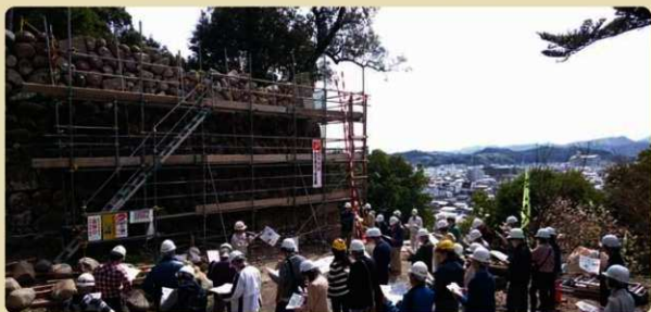
県指定史跡 永山城跡 災害復旧工事
