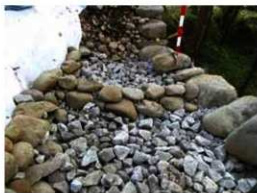
2工区グリ石列施工状況
