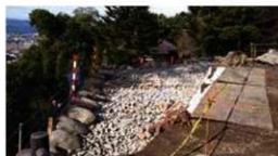
1工区グリ石列施工状況
