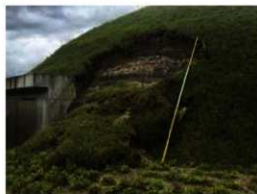
墳丘盛土流失状況
