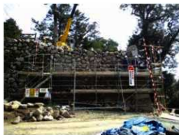
1工区石積み状況
