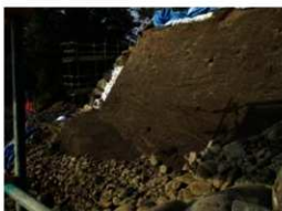
1工区背面盛土とグリ石（石垣10側から）
