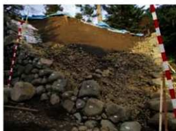
1工区石垣10に平行する裏留め石
