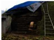
復旧工事施工状況
