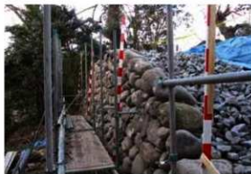
2工区石積み状況
