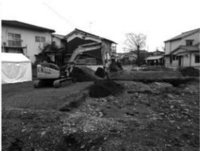
写真3 埋め戻し作業風景
