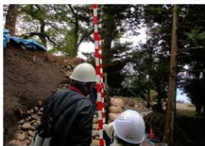
①高瀬委員による丁張り確認
