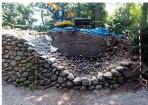
④解体完了
