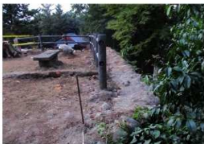
④石垣 8 上面のモルタル検出状況 1
