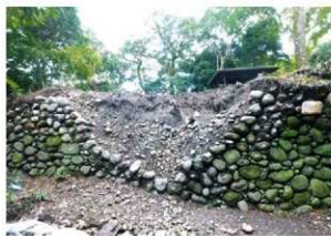
①解体前の状況
