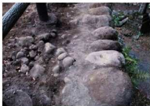
⑤石垣 8 上面のモルタル検出状況 2
