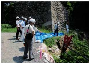
⑦ 平成 30 年度第 1 回修理委員会 (H 30.8.3)
