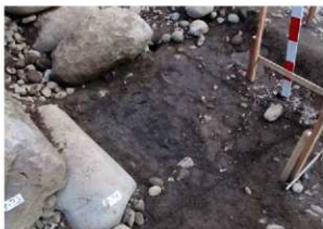
④根石の下、線の中を掘って割グリ石を入れる
