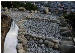
⑥円礫による石列施工状況 2
