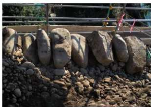
②控えの長い築石(石垣10の5段目)
