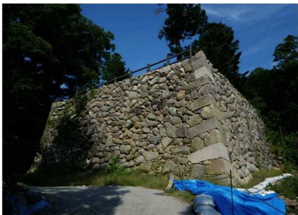
石垣9・10 出角部 竣工
