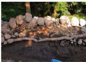
②裏止め石 石材も小さい
