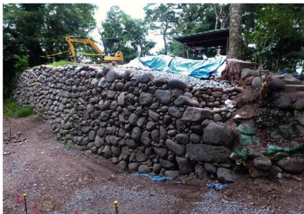
②石垣 2-2 積み直し状況
