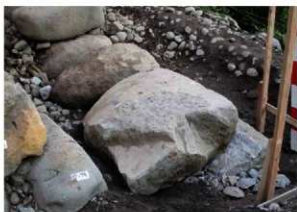
②角石根石の据え直し状況 2
