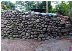
⑦積み上げ完了
