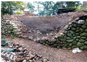
⑧解体完了
