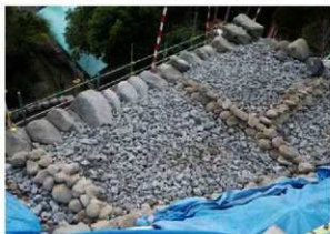
⑤円礫による石列施工状況 1
