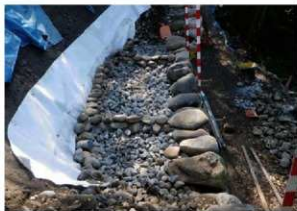
⑦石列施工状況
