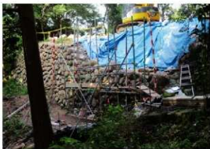
⑥積み上げ状況
