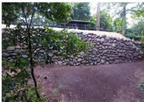
⑧天端施工完了
