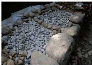
⑤石列施工状況
