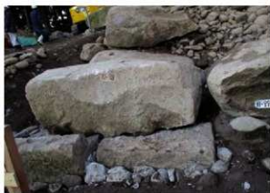
①角石根石の据え直し状況 1
