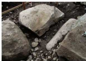
①角石根石検出状況 築石から避難している
