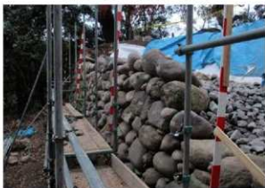
⑥積み上げ状況
