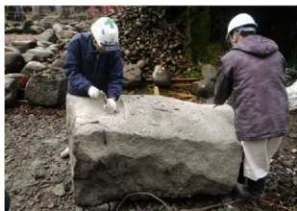
③崩落で破損した角石の新材加工状況
