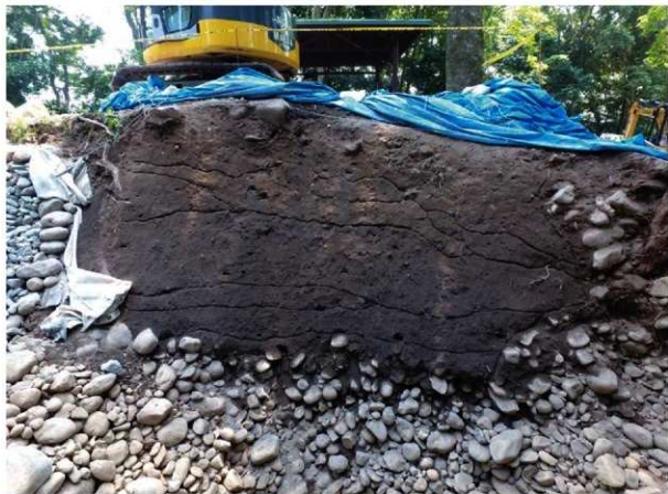
写真2 2-2工区背面土層写真
