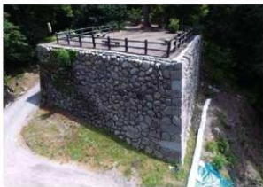
⑧施工完了状況
