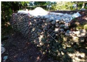
⑧積み上げ完了状況
