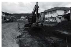
写真1 機械作業風景
