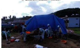
⑤ 埋没廃棄物撤去作業風景
