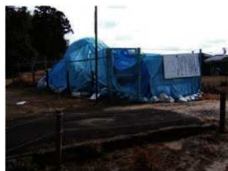
写真 2-5 仮設覆屋施工前
