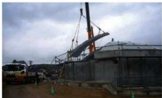
①屋根材設置状況③
