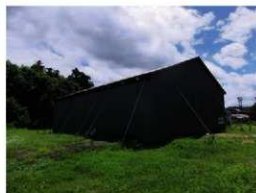
写真 2-7 仮設覆屋完成
