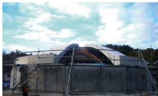
②屋根材設置状況④
