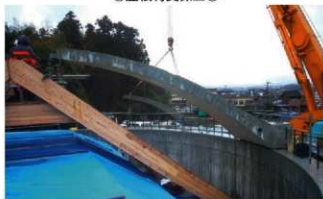
⑥屋根材支保工②
