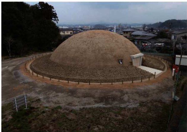
完成後の1号墳保護施設
