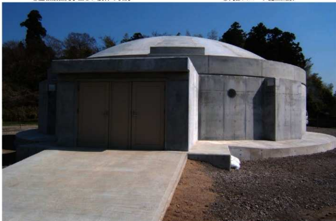
③屋根設置完了並びに脱枠の状況
