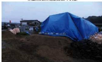
⑥ 産業廃棄物撤去後の状態
