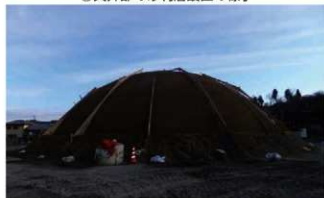
④天井部の砂利層設置の様子
