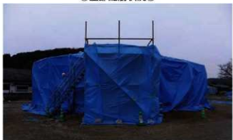
⑤ 壁部配筋状況①
