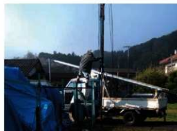
写真 2-4 アンテナ移設工事
