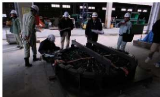
②屋根材の配筋と型枠②
