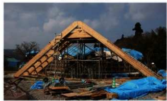
③ PCa 完成状況
