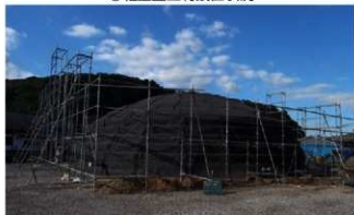
②軽量盛土材設置状況
