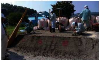
目的の締固め特性を得る確認のため実施。京都大学三村教授も立ち会いを行い、プレートタンパーと人力を採用。
