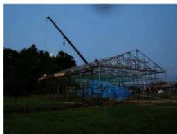
写真 2-6 仮設覆屋設置工事
