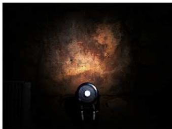
写真5-9 1号墳奥壁の様子 (平成29年2月撮影)
