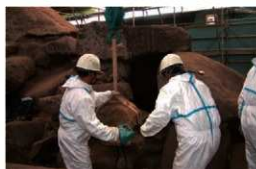
写真 2-11 間詰工事風景
