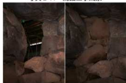
写真 2-12 間詰工事 (左：着工前、右：竣工後)
