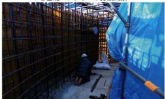
③ 基礎コンクリート打設風景
