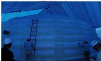
軽量盛土のため上層に発泡ウレタンを塗布。周囲への飛散防止のためシート養生。
