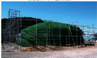
砂利層を設置するためのネット。
