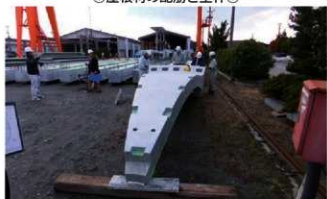
①屋根材の配筋と型枠①
