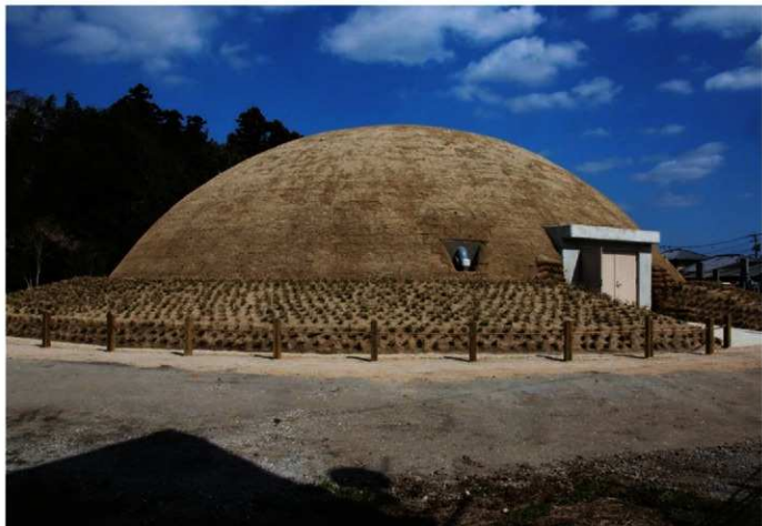
①施工完了①
