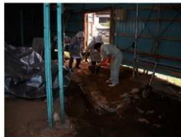
写真3-9 1トレンチ調査風景
