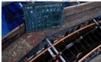
④ 基礎コンクリート養生風景
