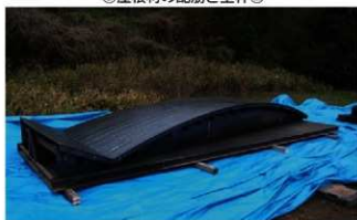
②屋根材の配筋と型枠②
