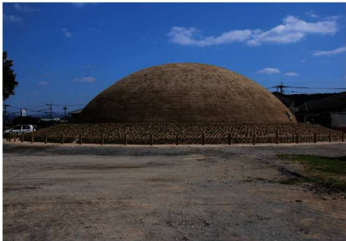
②施工完了②
