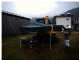
写真 3-7 地耐力試験風景
