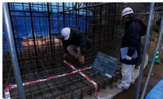
② 基礎配筋検査風景
