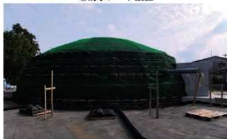
キャピラリーバリアのため、砂利土壌につめて躯体の段に沿って設置。同時にマウンドを浸透してくる水の排水工事も実施。
