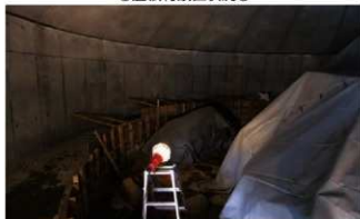
内部スロープは基礎の天端を利用し、荷重軽減のため発砲ウレタン材でかさ上げて施工した。
