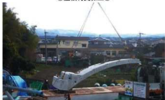
⑤屋根材支保工①
