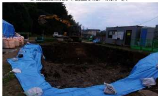
④ 覆屋撤去後の養生状態（南から）
