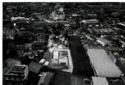
調査区全景 (北から)
