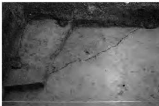
5 トレンチ1号溝
