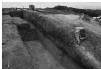
墳丘築造状況
