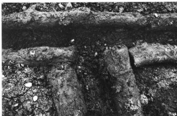
2. T-4 暗渠排水路接合部
