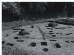
掘立柱建物完壁状況
