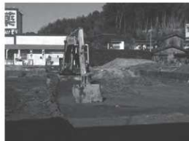
写真2 重機作業風景
