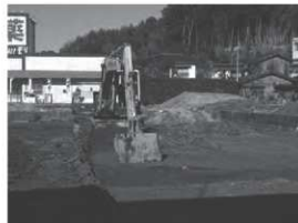
写真2 重機作業風景
