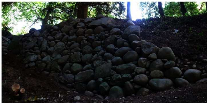
1. 搦手門 本丸北石垣東 (番号 3) 東側検出状況 (北から)
