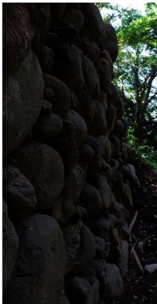
3. 天守跡西石垣 (番号 2) 検出状況 (北から)
