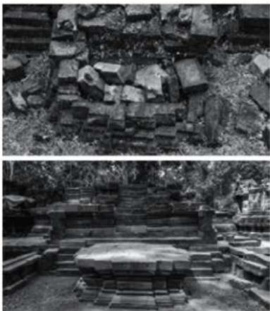
図72 東テラス仏像台座（上：解体前、下：再構築後）
