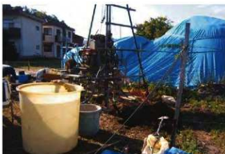
⑧1号墳周辺ボーリング調査風景（北東から）
