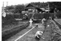
写真2 重機作業風景
