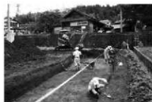
写真2 重機作業風景
