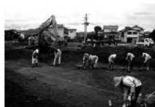
写真1 調査作業風景
