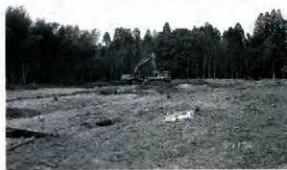
写真2 表土除去風景
