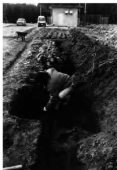
第4図 2トレンチ作業風景
