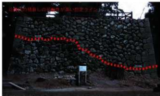
写真 27 石垣 9 の積み直しライン
