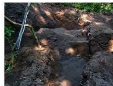
① 北ルート 予備1次1トレンチ 整地層の道路と考えられる、裾張状を階段状に削り水切 り状の溝を備えた小さな平場が検出された。
