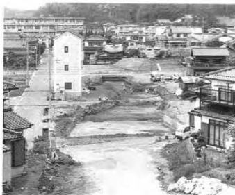
C区全景（南より）
