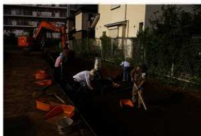
3. 表土剥ぎ風景
