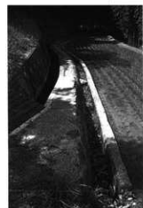
水路からのコンクリート製引込み溝
