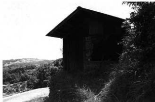
深山水路の終点近くにある水車小屋
