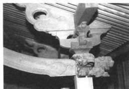
写真10 同 向拝組物・海老虹梁・手挟
