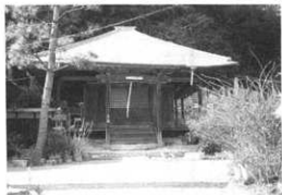
写真25 地福寺観音堂正面
