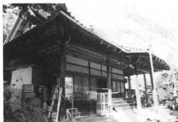
写真1 法林寺本堂正面
