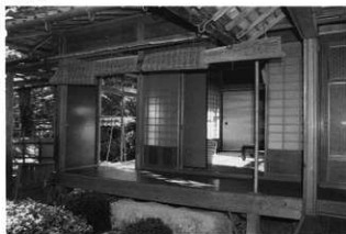
離れより座敷を望む
