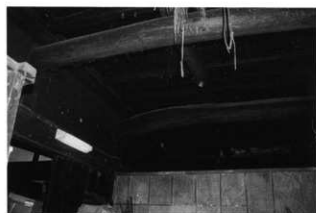
土間上部の梁組
