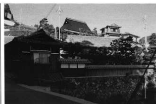
屋敷構え遠景 (その1)
