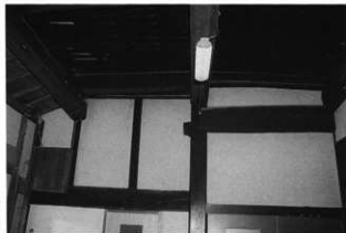
土間上部梁組をみる
