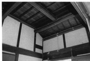
土間上部の梁組
