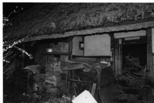
外観・出入口まわり
