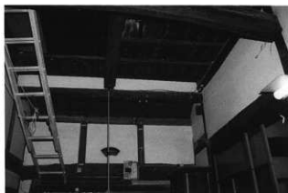
土間上部の梁組
