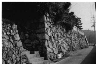
屋敷南面の石垣
