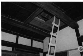
土間上部の梁組
