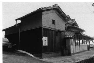
主屋背後の土蔵外観
