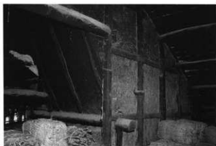
カマヤ上部の小屋組
