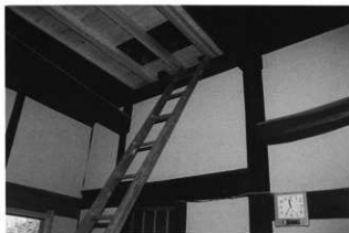
土間上部の見上げ・小屋裏への出入口
