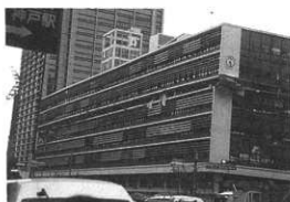
写真1 兵庫県南部地震で大被害を受けた神戸市役所
