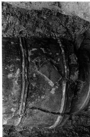
2. 井戸H-10 3段目井筒通透孔閉塞状況 (西から)
