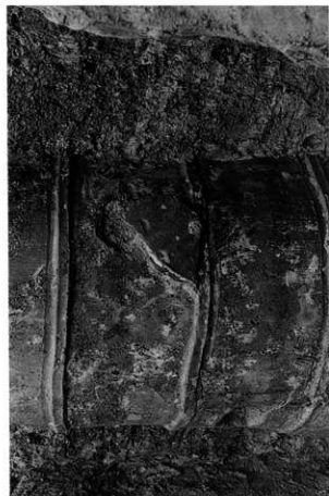
1. 井戸H-10 3段目井筒通透孔閉塞状況 (西から)
