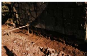
土橋門東石垣西面 (3610W) 下部 全景
