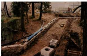
裏口門周辺 (西から)
