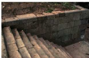
石段1 南側壁石垣
