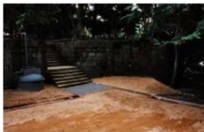
調査区整備後状況（北西から）
