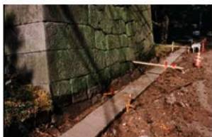
土橋門西石垣東面 (3620E) 下部 全景
