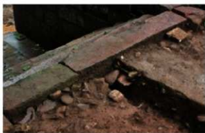
石段1 最上段 背面の根固め石 (南から)
