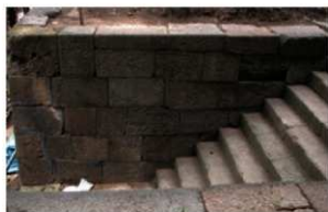
石段1 北側壁石垣
