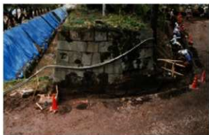
裏口門東石垣西面 (2700W) 全景
