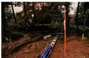
裏口門周辺 (東から)
