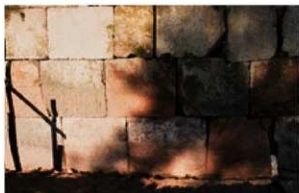
裏口門西石垣東面中央 下部検出状況
