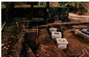
裏口門周辺 (南東から)
