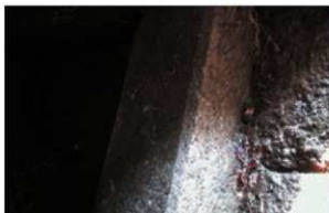
石組溝1内部 支柱の面取り状況 (南西から)
