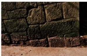
土橋門西石垣東面北側 下部検出状況
