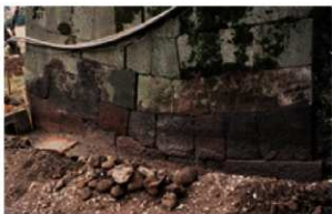
裏口門東石垣西面 下部検出状況
