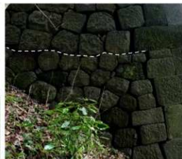
石のサイズは段ごとに大・小のまとまりがあり、中部より下に小サイズが集中する傾向。隅角部と築石間に縦方向の連続した目地の開き (3~11cm)
