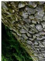
1石が隅に逸出し、 周辺の石も引きずられて 局所的に孕み出す
