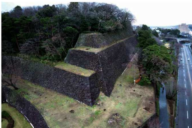
2 1130E、1131E 南東から
