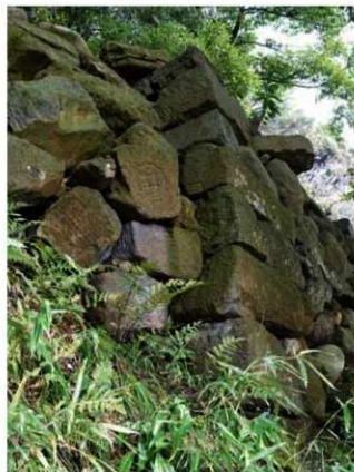
2 1640W、1641S 西から 前方向へ弓なりに変形
