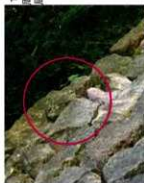
1石が隅に逸出し、 周辺の石も引きずられて 局所的に孕み出す
