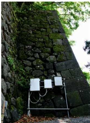
4 6500N 北西隅角部 北から・西から
