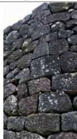
シノ平角の上から6段目で積層加工が変化
