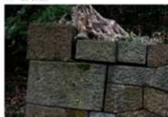
天端角石に転用材
