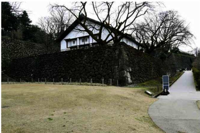
2 1710N・E 北東から
