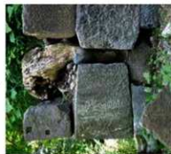
天端内石の前割れと角盛石の崩落。 その背後に樹木根(柱)が透伴
