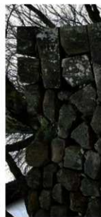
天端角石の道出しと掛け落ち
