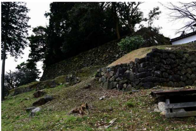
3 1241E 南東から
