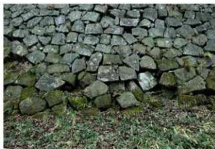
写真24 小峰城跡帯曲輪北部の石垣
