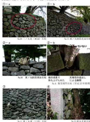
写真8 樹木と石垣変形
