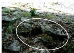
写真14 積み石の抜け落ちの例
