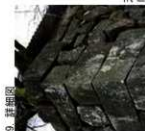
天端角石の取出しによる継ぎのズレ
