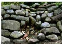
築石（4石）崩落後、表込め等が露出 2014年10月末以降に崩落
