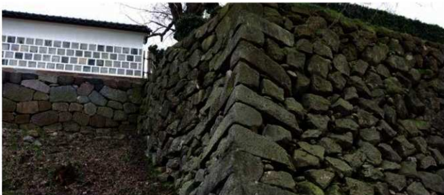
5 3440E 北東から
