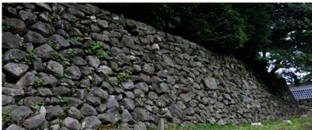
2 1221E 南東から
