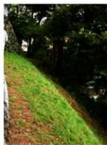
石垣前の斜面
