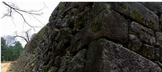
4 3440N 北西から
