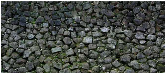
2 3440N (中央部) 北から
