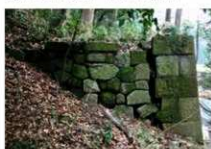
No.4 (6430W 散寄屋敷門下泉水縁石垣北槽台)
