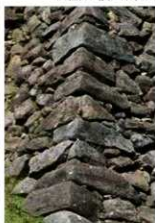
2. 東ノ丸東(下段)北東 1131S・E
