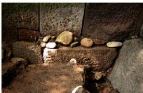
2005-8地点 本丸西面石垣折れ部南面 (1340S) 根石
