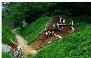
2006-3地点 斜面精査 西から
