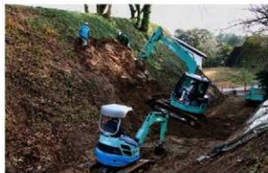
2008-2地点 埋め戻し作業
