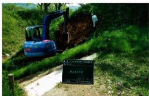
2006-3地点 表土除去 西から
