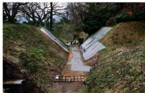
2008-1・2008-2地点 埋め戻し完了状況
