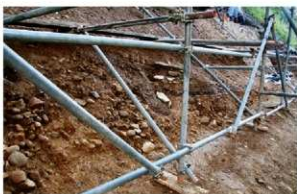
2008-1地点 調査地点南壁精査（下位）
