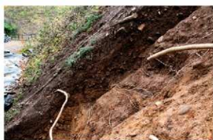
2008-2地点 調査地点西壁 (下位)
