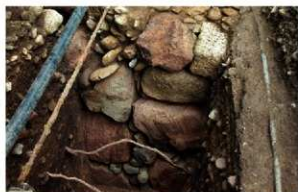
2006-2地点 本丸西面石垣下部 (1352W)
