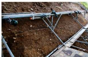
2008-1地点 調査地点南壁精査（中位）
