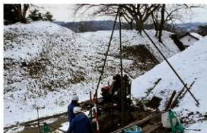
ボーリング調査作業風景 (本丸北部調査区)
