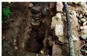
2006-2地点 調査地点北西部 西から
