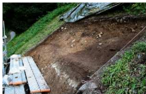
2007-1地点 斜面精査
