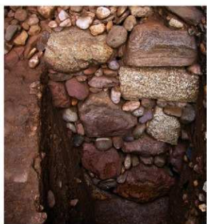
2005-2地点 本丸西面石垣下部(1352W)
