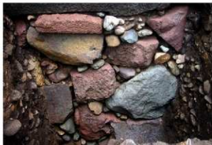
2004-7地点 本丸西面石垣下部(1352㊦)
