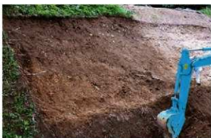
2008-1地点 表土除去 北東から
