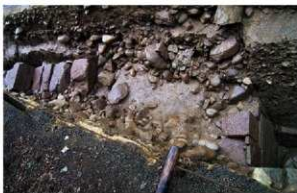
2006-1地点 三階櫓台石垣南面・西面(1010S・W) 北から
