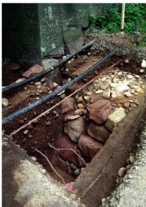
2005-2地点 調査地点南部 南西から
