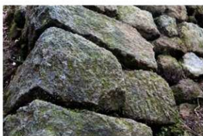
5 隅角部の石材加工（角石：割、角脇石：ツル）
