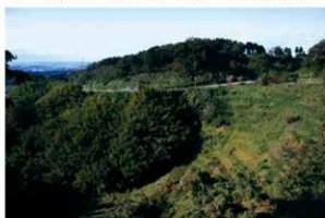
6 長坂では谷斜面をトラバース(田上本町地内)
