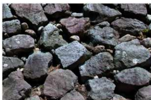
2期新 (本丸南東 辰巳槽下)
