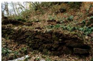
2 石垣と上面の通路
