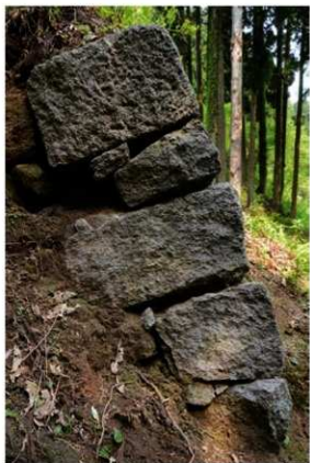
1 SW1南東隅角部（南面）
