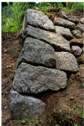
4 SW1南東隅角部（東面）
