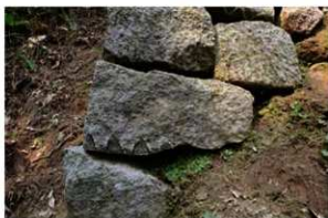
6 三角形矢穴痕が残る角石の割面
