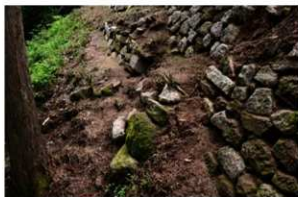
4 南部の下段石垣(奥)と捨て石(手前)
